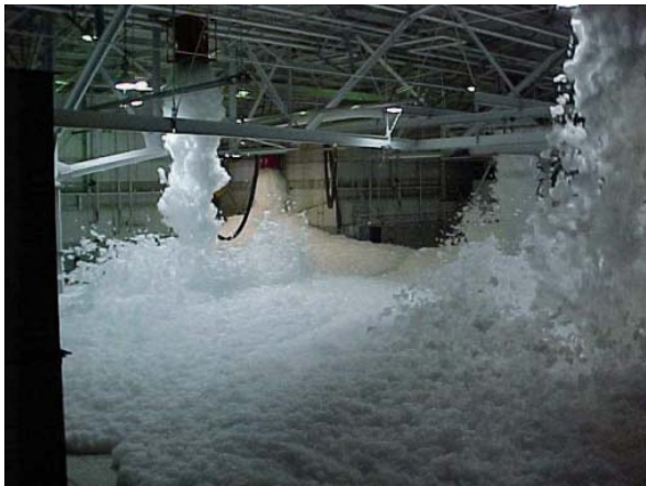
Figura 8: Descarga de Espuma de Alta-Expansión. Foto Cortesía: Kiddle Fire Fighting
