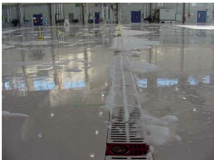
Figura 11: Drenajes del suelo en un Hangar de Aviación.
